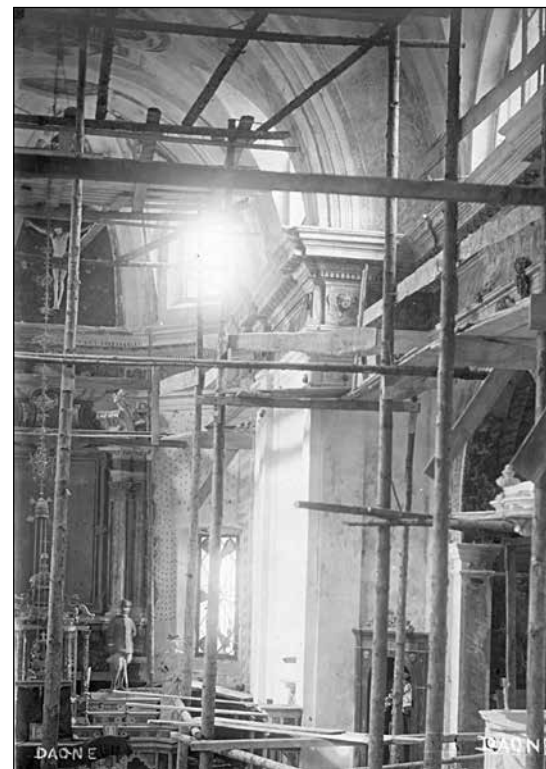
Cantiere nella chiesa di Daone. Foto: Museo Storico italiano della Guerra di Rovereto
