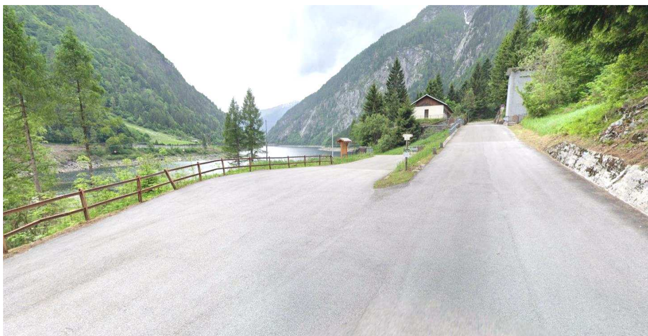
Incrocio fra la strada locale esistente che conduce alla centrale di Boazzo e la strada che porta a Malga Bissina
