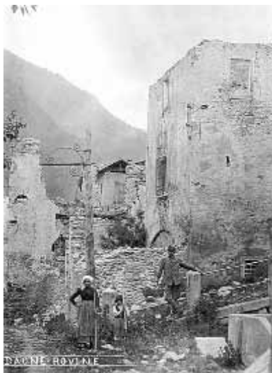
Daone, rovine - Primavera 1919 (I pilastri e le ringhiere sono ancora in essere a Daone – salita da via Orti verso via Saverio)
