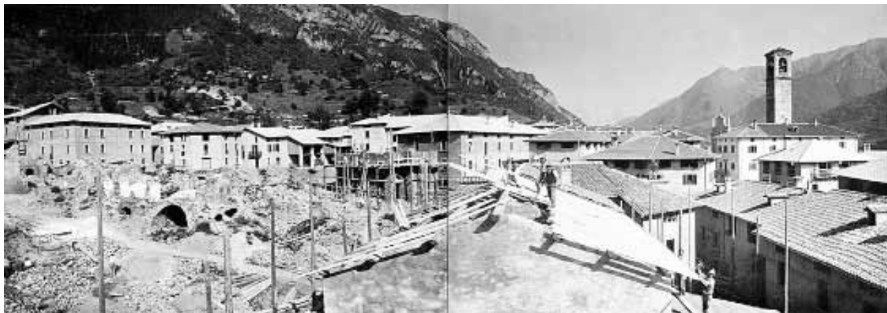
Praso, le prime ricostruzioni dopo la Grande Guerra.
